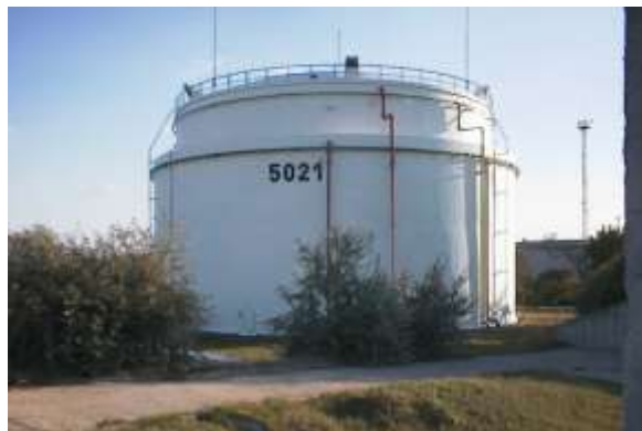
29. ábra: Belső úszótetős tartály (forrás: BM OKF)
