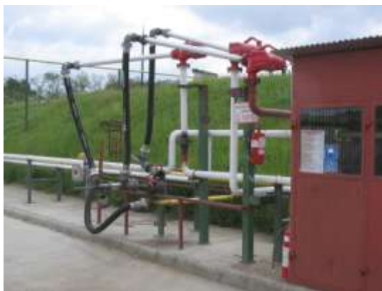
36. ábra: Közúti tankautó-töltő állás (forrás: BM OKF)
