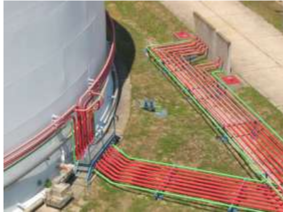
34. ábra: Oltóberendezés vezetékei (piros: habbaloltó, zöld: palásthűtő), forrás: BM OKF
