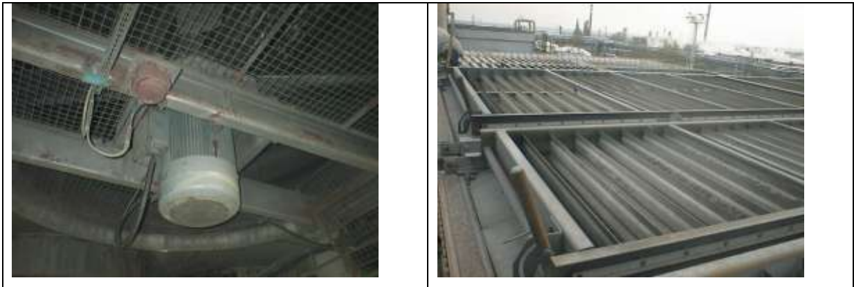
23. ábra: Légekondenzátorok (forrás: BM OKF)
