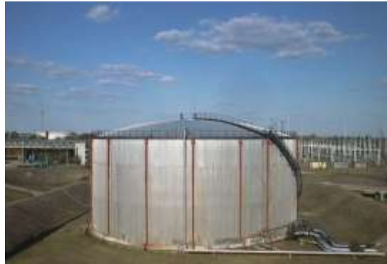
27. ábra: Merevtetős tartály (forrás: BM OKF)
