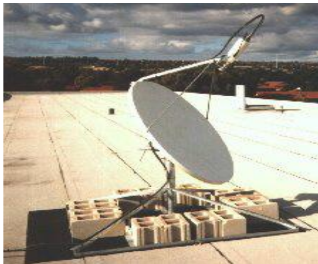
3. ábra VSAT állomás kültéri egysége
