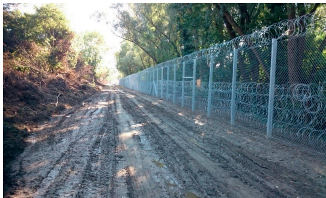
35. ábra: A magyar államhatáron telepített kombinált drótzár
