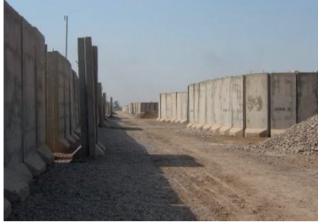
33. ábra: T-fal alkalmazása létesítmény külső határvonala védelmére
