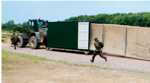
21. ábra: HESCO Raid gyors telepítése
