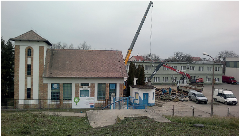
9. ábra: Tápéi szivattyútelep rekonstrukciója (a szerző felvétele)
