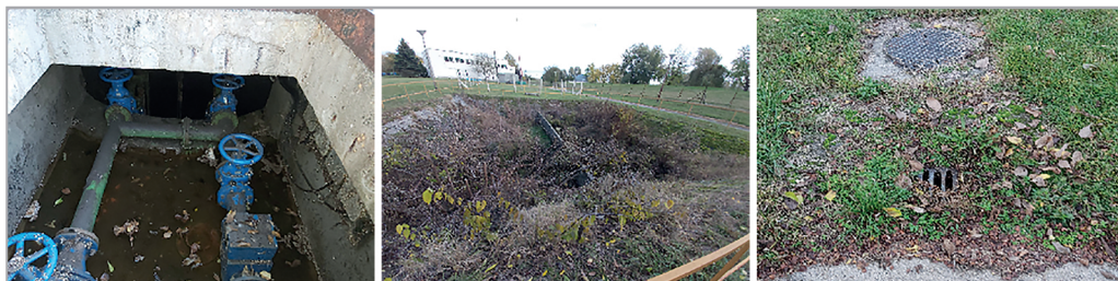
9. ábra: Első ütemben elvégzendő legfontosabb javítások, az átemelőakna (balra), a technológiai vízkezelő műtárgy (középen) és víznyelők (jobbra) rendbetétele (a szerzők felvétele)
