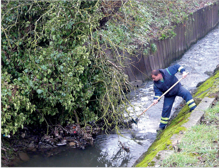
3. kép: Torlaszelhárítás (Hosszúrési-patak) (a szerző felvétele)
