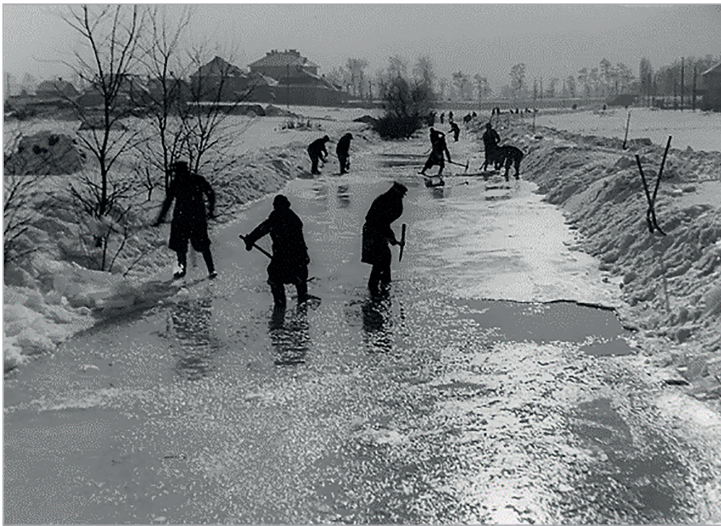
4. kép: Jég eltávolítása kisvízfolyáson (a szerző felvétele)
