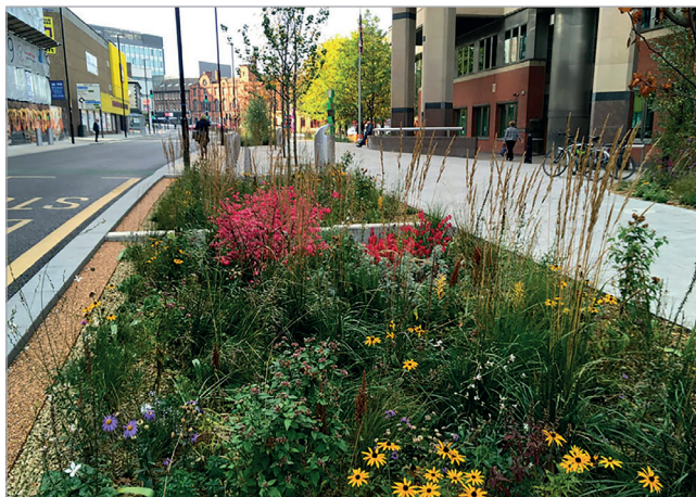
2. kép: Út melletti esőkert – Aikenhead Road, Glasgow, Egyesült Királyság [11] (a szerzők felvétele)
