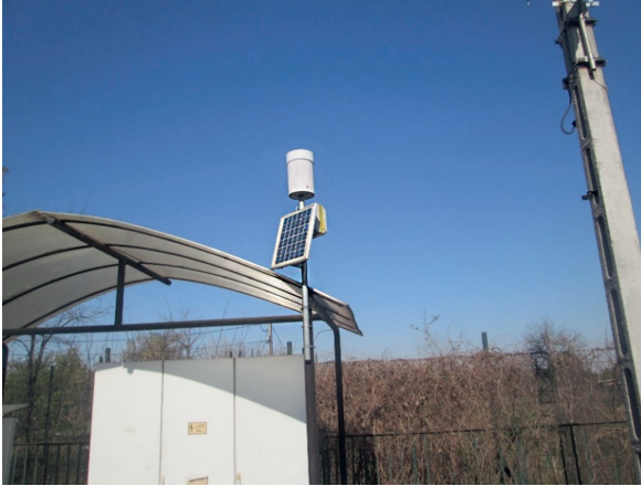
2. ábra: Egy FCSM-csapadékmérő jellemző elrendezése (Lőrinci út) (FCSM Árvízvédelmi Osztály felvétele)
