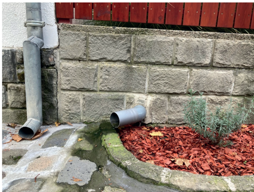
1. ábra: Az ingatlanok tulajdonosai a csapadékvizet még a növényzet öntözésére sem használják; az általános, szabálytalan gyakorlat a víz kivezetése az ingatlan előtti járdára (a szerző felvétele)
