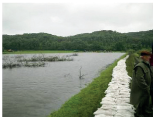
27. ábra Gátmagasítás nyúlógáttal Forrás: KDTVIZIG 2010
