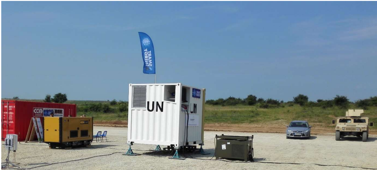
18. ábra: Előkészített tábori villamos hálózat részlete a CL15 nemzetközi logisztikai gyakorlaton Várpalotán (saját felvétel)
