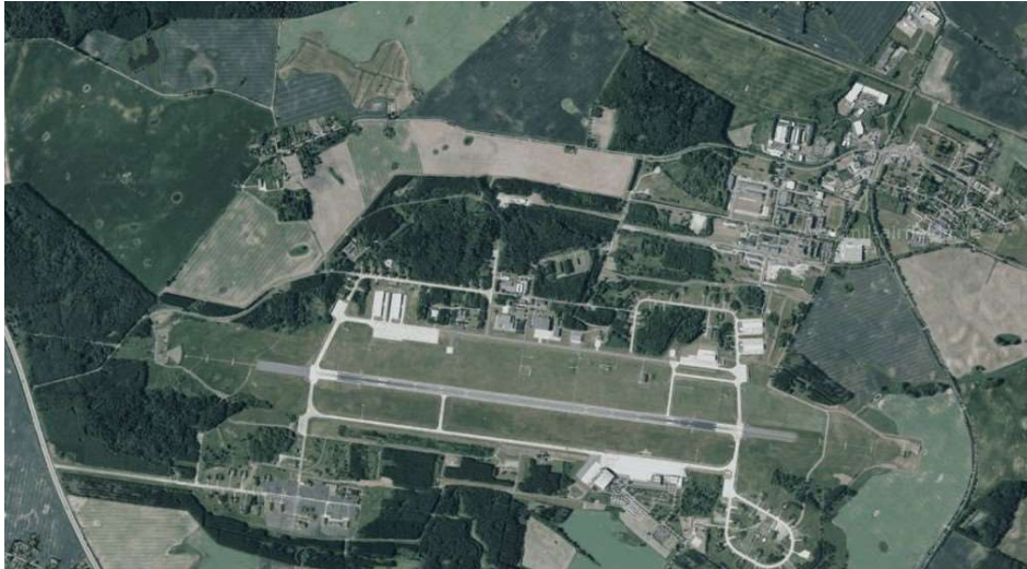
41.) sz. kép: Laage repülőtere, az áttelepülésünk fogadó repülőtere 961
