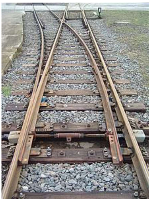
38. ábra: Csúcssíneket összekötő rúd forrás: https://docplayer.hu/21162195-1-a-vasuti-kozlekedes-alapfogalmi.html
