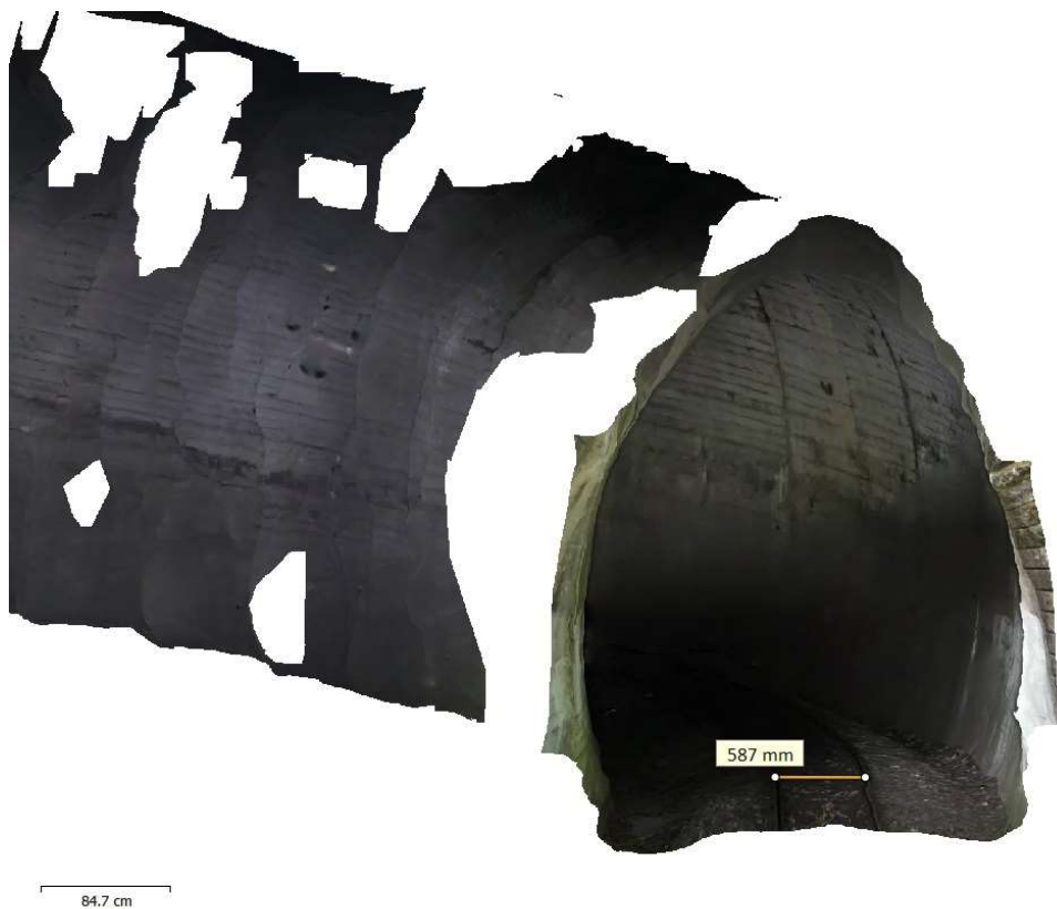
A nyomtávolság meghatározása a modell alapján
