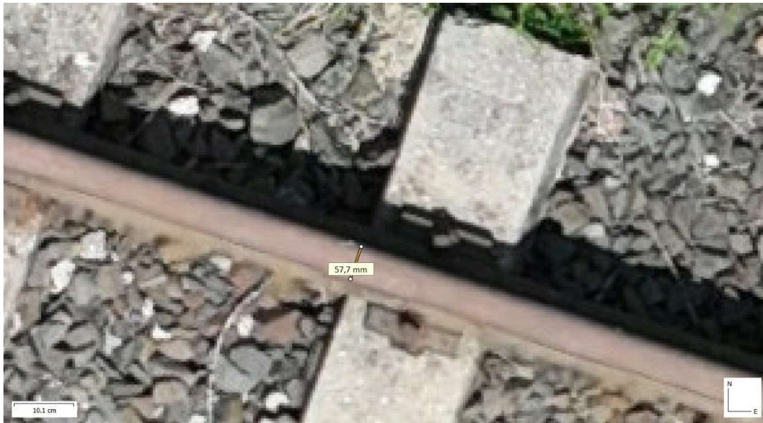
A sínfej méretének megállapítása a modell alapján (a valóságban 66,8 mm = 48 kg/fm sínprofil)
