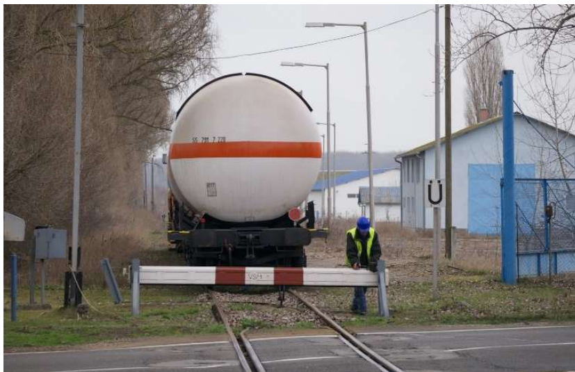
15. ábra: Vágányzáró sorompó
