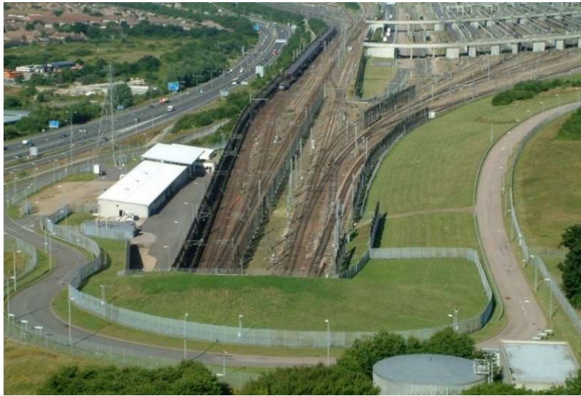
32. ábra: A csatorna-alagút bejárata (Anglia)
