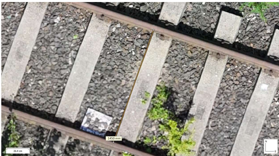
A nyomtávolság megállapítása a modell alapján (a valóságban 1435 mm)
