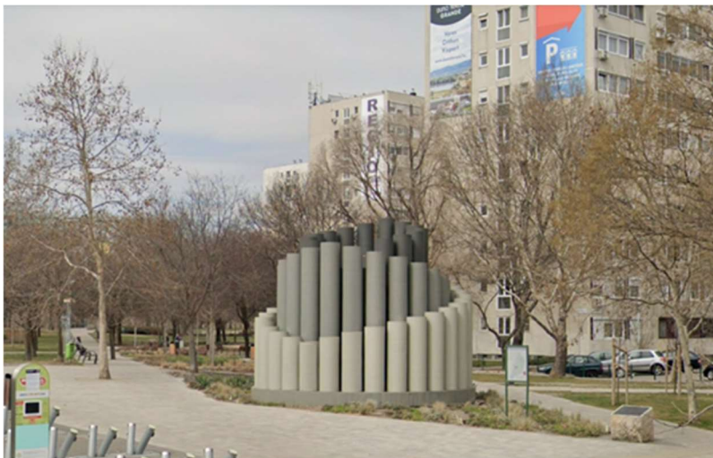
35. ábra: Az M3 metró szellőzőberendezése köztéri „szoborként” forrás: google.com/maps
