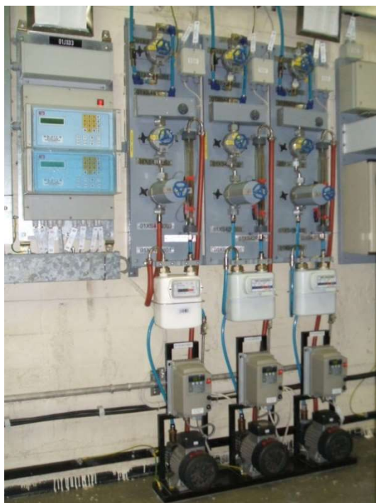
11. ábra: Párhuzamos ágú aeroszol és radiojód mintavevő egység. Forrás: [244, 242]
