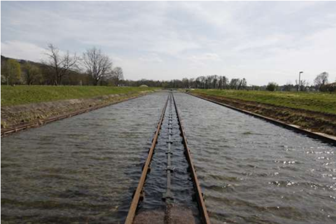
11. ábra: Kotróval ellátott talajvízdúsító műtárgy Drezda Hosterwitz vízbázisán (a szerző fényképe)
