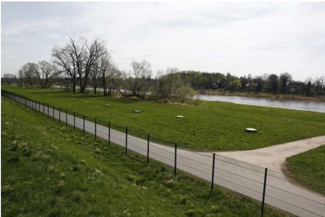
10. ábra: Parti szűrésű kútsor az Elba folyó partján Drezda Hosterwitz vízbázisán (a szerző fényképe)
