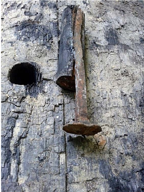
5. ábra: A nagyobb szeg, az eredeti fa szerkezeti elemekkel – a facsap és a szeg csapfuratból való kiemelését követően
