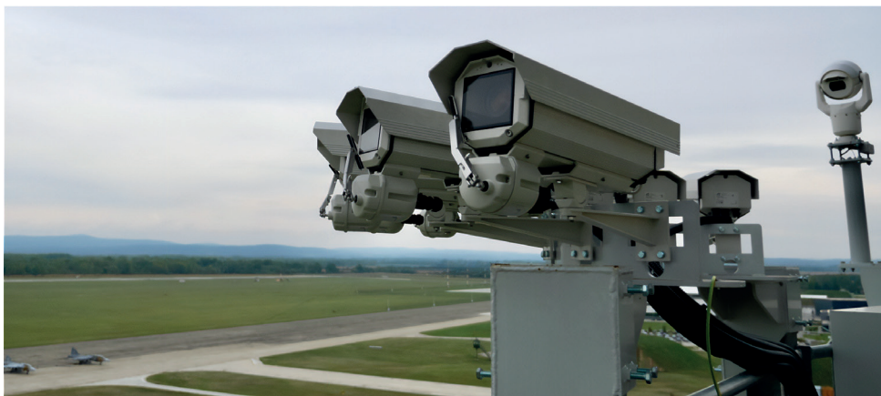
1. ábra LHPA rTWR kamerakonfiguráció [a szerző felvétele]
