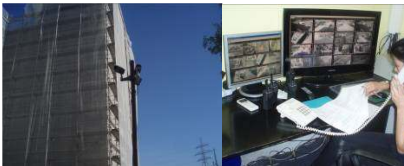
4. kép: A kamerák az építkezésen biztosítják az események valós idejű megfigyelését a diszpécsterszolgálat számára
