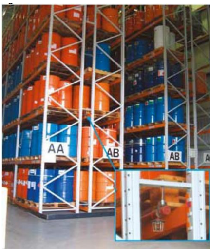
3. kép: Fokozottan tűz-, vagy robbanásveszélyes anyagok oltása a tároló sorok közé beépített habbaloltó berendezés alkalmazásával. Forrás: [70]
