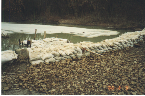
2. ábra: Homokzsákkal elzárt tározóbéli vízfolyás
