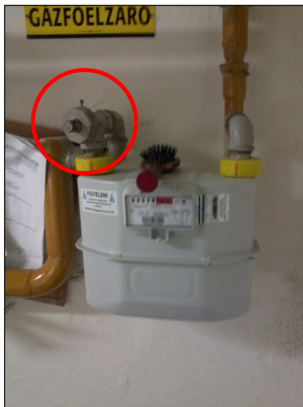
13. kép Az elzárás fogantyú hiányában nehézkes lehet [Készítette: a szerző]
