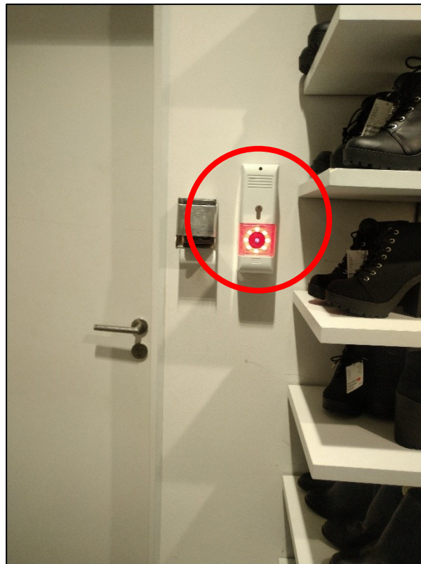
30. kép Villamos szabályozású vészkijárat rendszer egy magyarországi bevásárlóközpont cipőboltjában [Készítette: a szerző]
