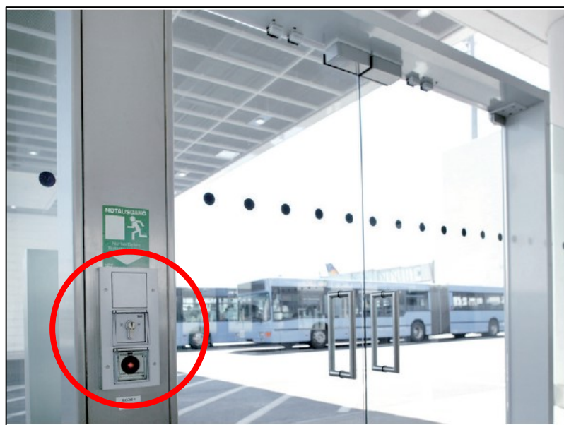
38. kép Nyomógombbal nyitható vészkijárat MSZ EN 13637 szerinti kialakítással [189]
