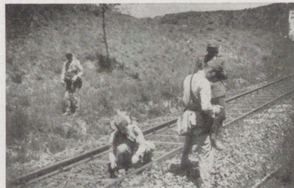
Távbeszélő vonal építése.
