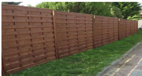
30. ábra: A közösségi kontrollt kizáró kerítés 62
