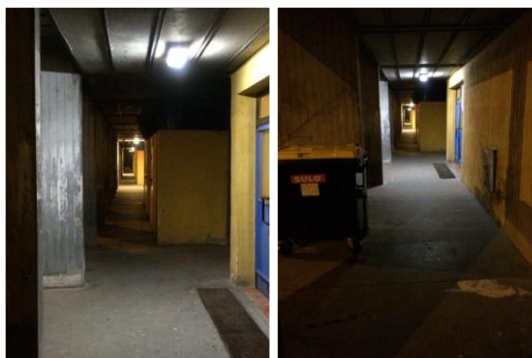
28. ábra: Panelépület árkádsora Békásmegyeren (saját fotó)
