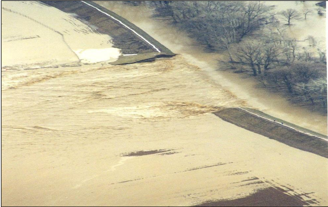
2. sz. kép: Tarpai gátszakadás 2001-ben
