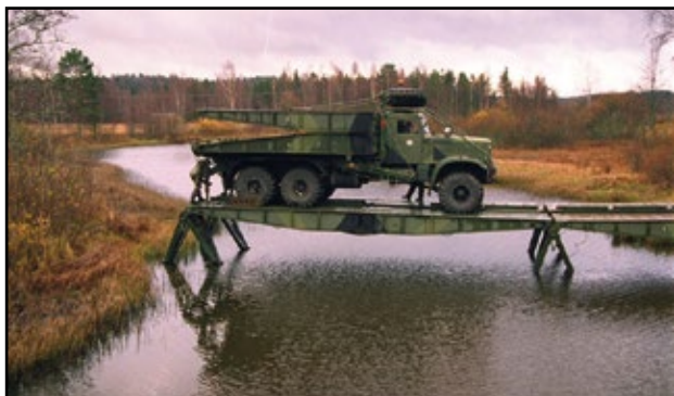
285. kép TMM mobil híd
