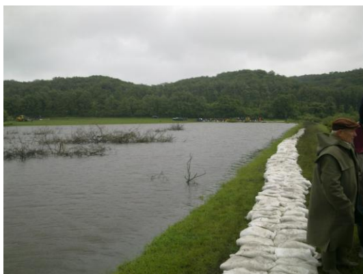
5. sz. fotó: Gátmagasítás nyúlgáttal Készítette: KDT VIZIG 2010.
