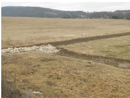
9. sz. fotó: 1. sz. tározó levezető árok Készítette: Bárdos Zoltán 2015.
