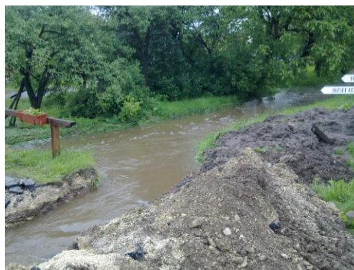
8. sz. fotó: Áteresz felbontása Készítette: KDT VIZIG 2010.
