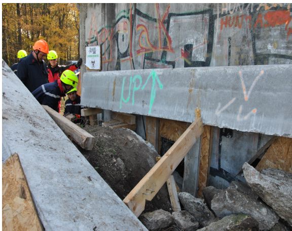
11. számú kép Romosodott épületben behatolási út megnyitás a Hortobágy Mentőcsoport 2017.10.20-i újraminősítő gyakorlata során Készítette: a szerző
