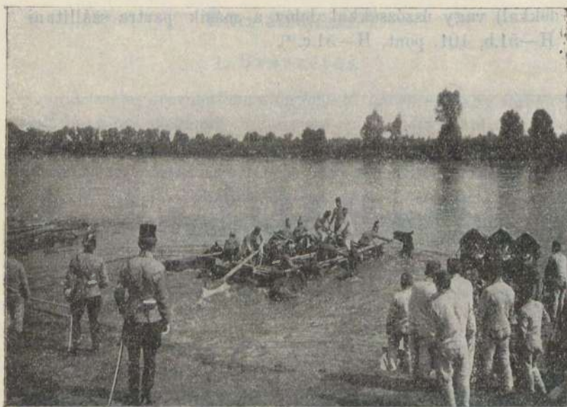
10 zsákból készült úszózsáktutaj, hozzákötött lovakkal, az átkelésre előkészítve.
