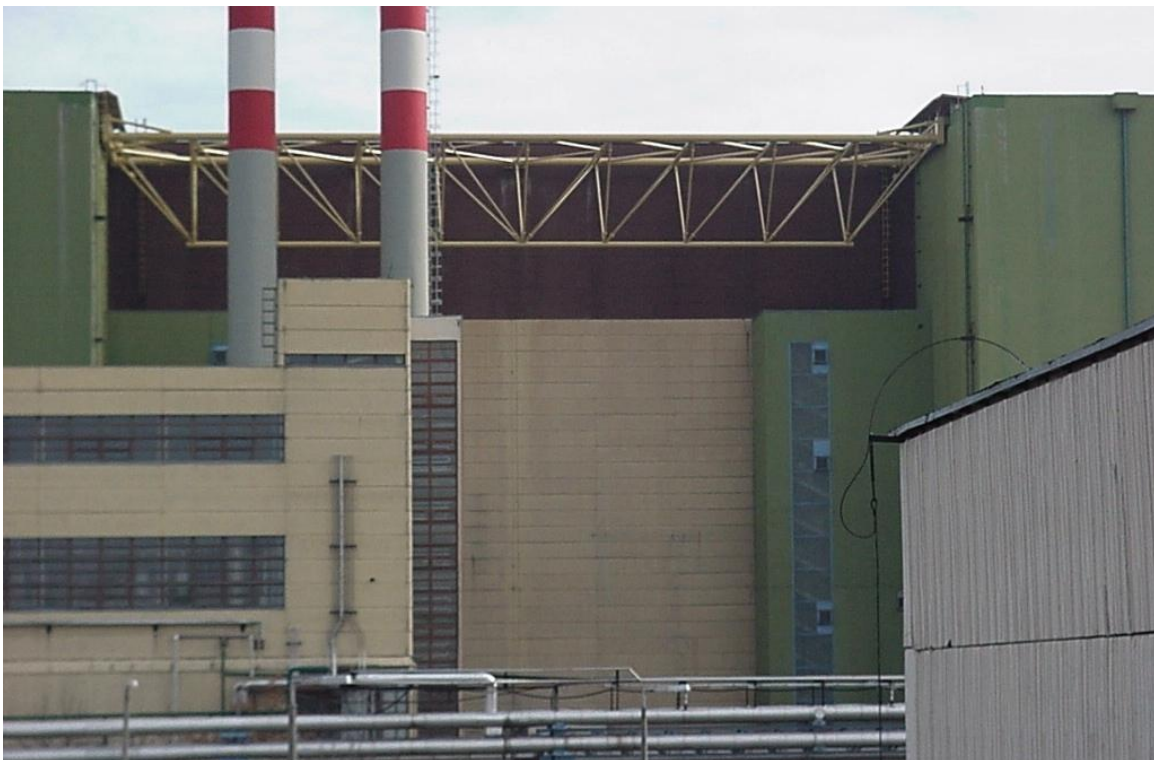
2. ábra. Hídszerkezet a lokalizációs tornyok között
