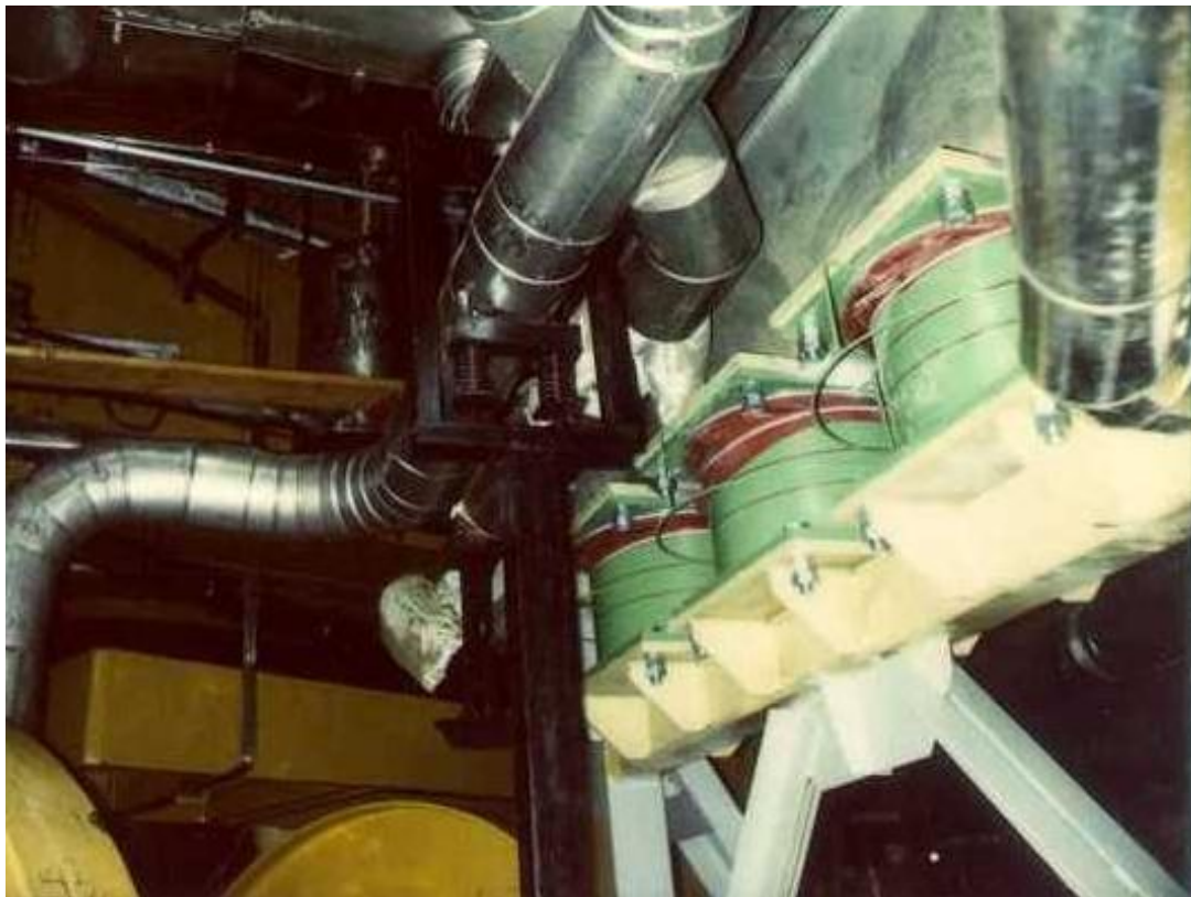
1. ábra. Viszkózus lengéscsillapítók a gőzfejlesztők alatt
