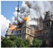
Andrássy úti palota, Budapest – átalakítás alatt lévő épület (félkész, elbontott szerkezetek) Nem volt kivitelezés folyamatban az átalakítással érintett területen, „csak” lokális javítások a tetőn!
