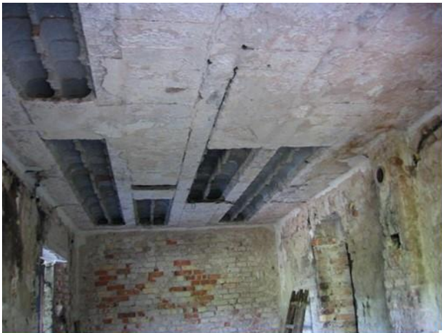
E-gerendás födém (tűzvizsgálat, 2007)
