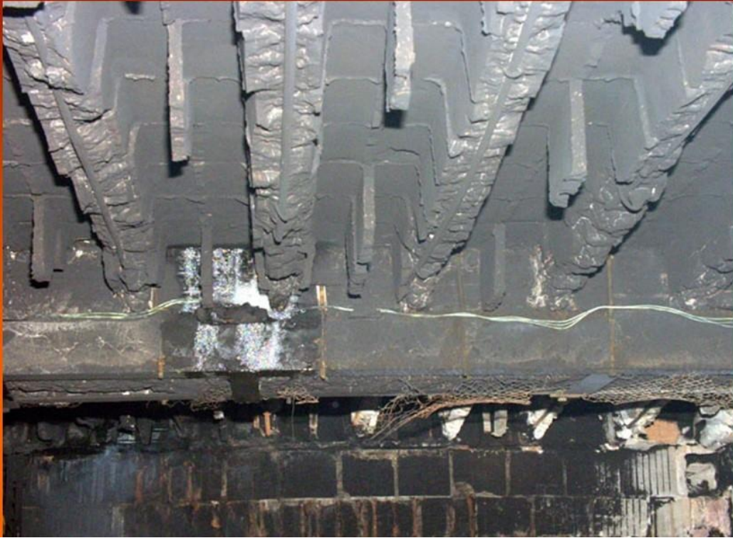
E-gerendás födém (tűzvizsgálat, 2007)
