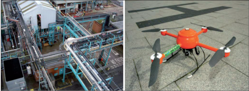
7. ábra: Vegyipari üzem csőrendszerének sérülése és a felderítésére alkalmazott UAS (forrás: Mika, 2009)
