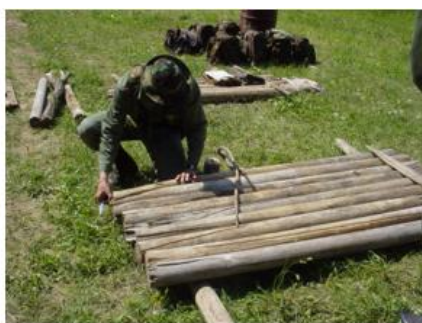
157. kép: Tutaj és hordótutaj készítése 34
