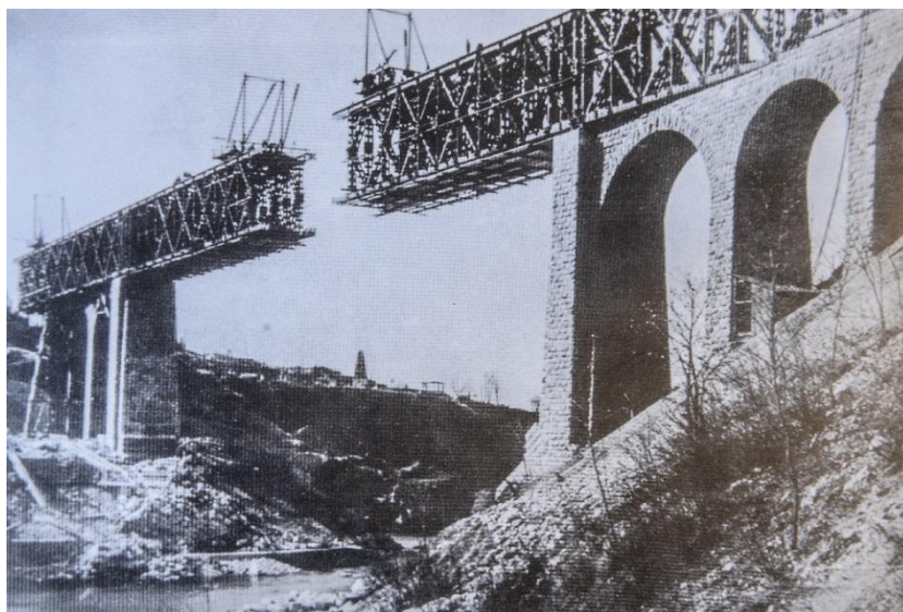
5. kép A Roth–Wagner hídmezők összezárás előtt. Jól látszanak a felső tartókra szerelt daruszerkezetek
