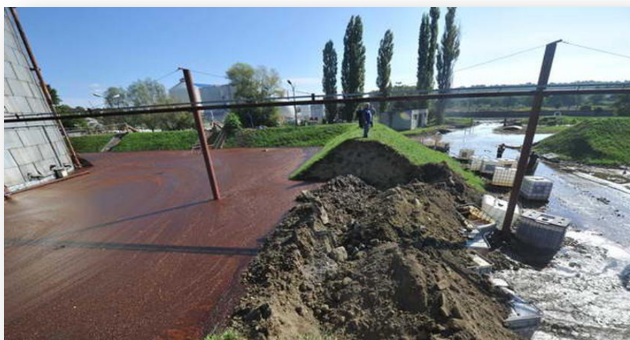
1. kép. A kaposvári cukorgyár átszakadt tárolótartálya.
