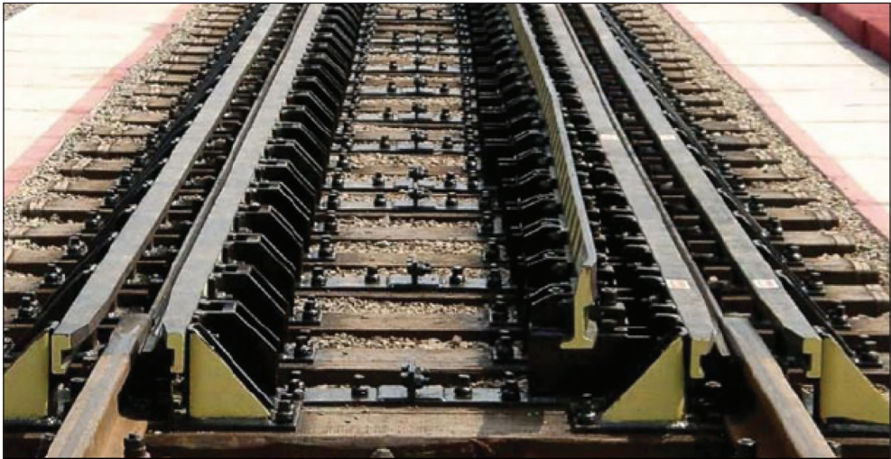
6. ábra: A nyomtáv váltó sínsvakasz [19]
