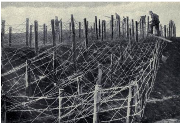
Fa- és fémkarókon elhelyezett drótzár leküzdése [36], [37]
