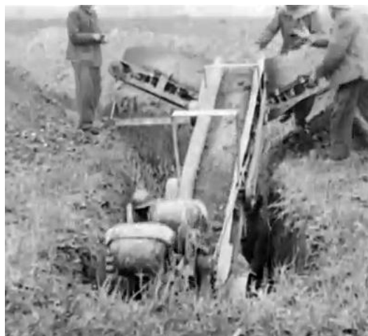
Francia „vedersoros” árokásó 94
