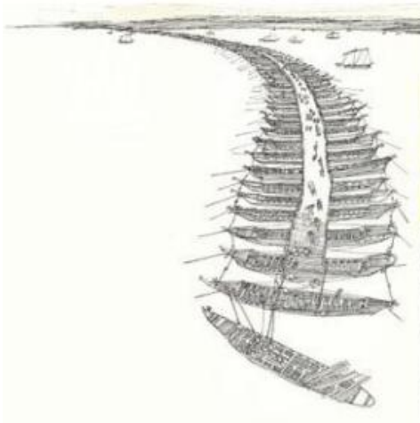
Xerxes hajóhídja a Dardanelláknál építés alatt 4
