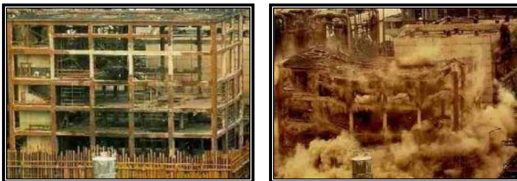
1. kép: Épületrobbantás a Peremartoni Vegyigyár területén 3
