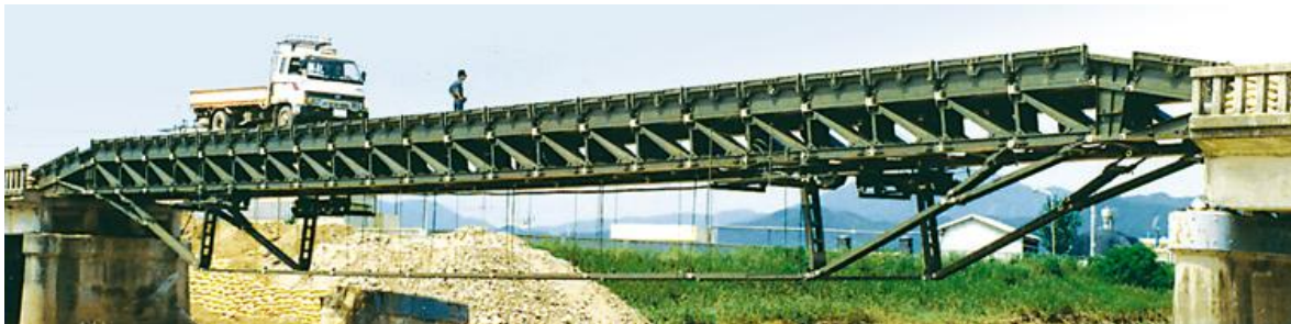
7. sz. kép Kettős megerősített tartószerkezetű híd 13
