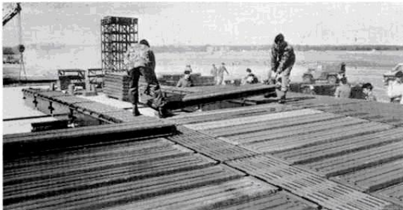
16. sz. kép „Felszálló rámpa” építése 29
