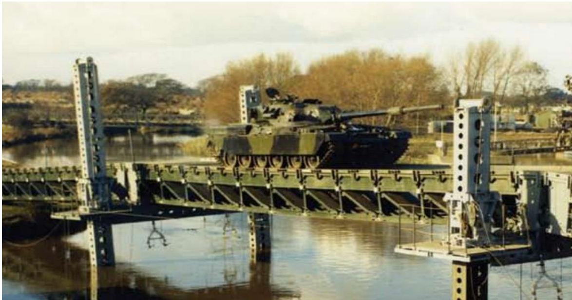
6. sz. kép MGB szállítható támasztópillér alkalmazásával 12
