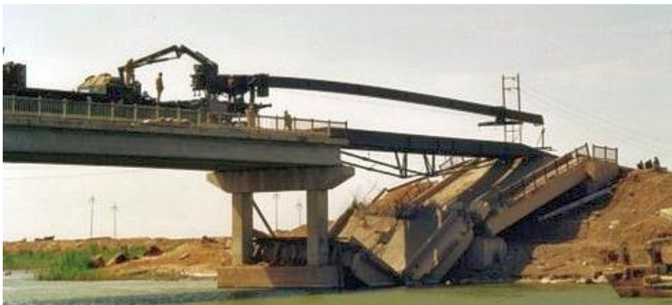
13. sz. kép GSB „nagy fesztávú híd” építése Irakban 26
