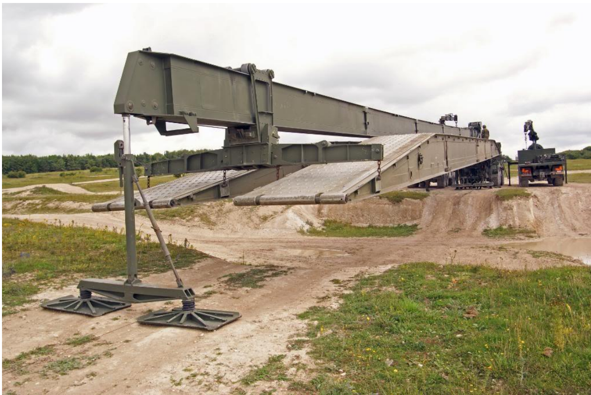
11. sz. kép Az „építőgerenda” alkalmazása a híd építéséhez 24
