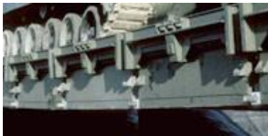
3. sz. kép Szimplatartós szerkezetű híd
