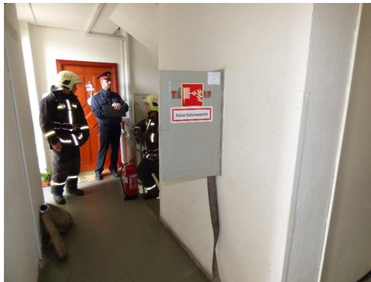
18.számú kép: Szerelés a szárazfelszálló vezeték használatával
