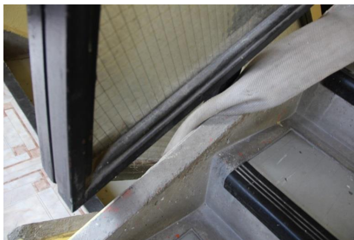
17.számú kép A korlát alá szorult tömlő (Készítette: Vincze Zsolt Készült: Budapest, 2013.október
