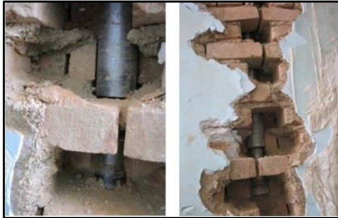
51. sz. ábra: Függőleges belső merevítés kialakítása a falazatban Forrás: [207; 5. o.] Készítette: nem ismert
