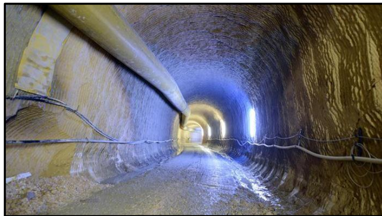
Városi árvízmentesítésre létesített alagút Máltán. Forrás: [146], Készítette: nem ismert
