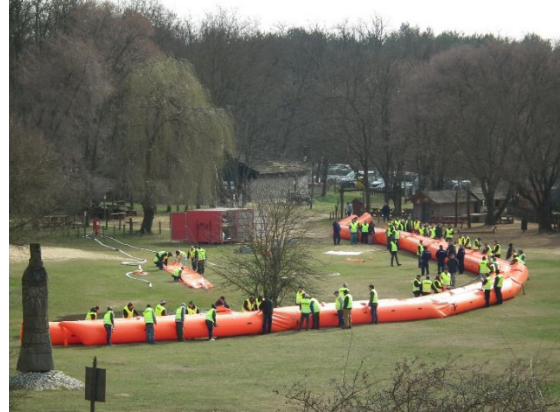
64. ábra: Homokzsákos kiegészítés, tömlőgát helyre szállítása. (forrás: Polgári Védelemért Alapítvány [136])
