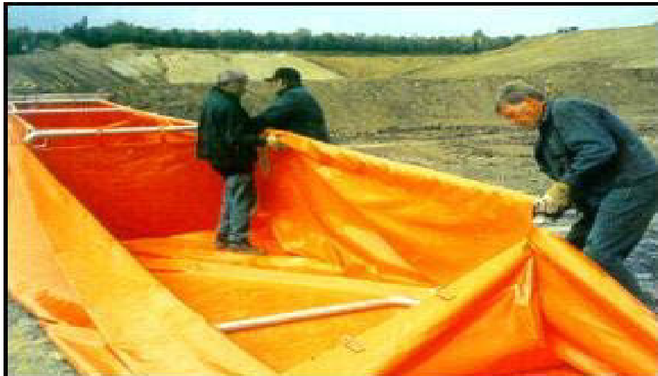
61. ábra: A mobilgát szerelése. (forrás. domo-bau.hu [134])
