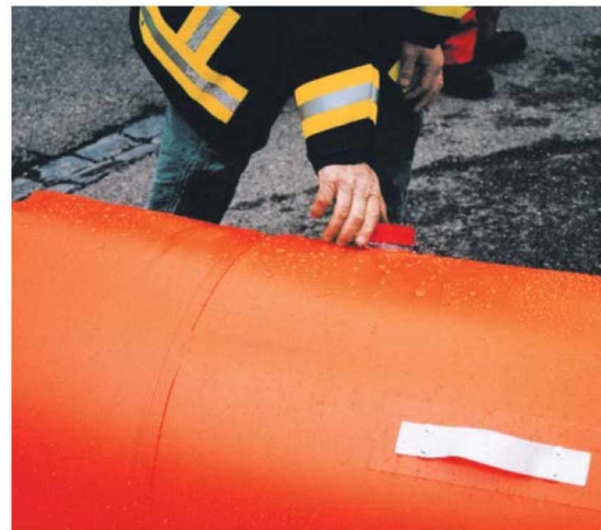
65. ábra: Tömlősgát összekapcsolása és feltöltése. (forrás: Polgári Védelemért Alapítvány [136])
