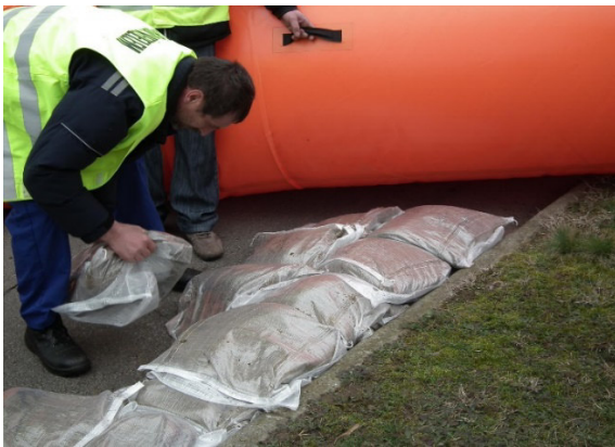
64. ábra: Homokzsákos kiegészítés, tömlőgát helyre szállítása. (forrás: Polgári Védelemért Alapítvány [136])
