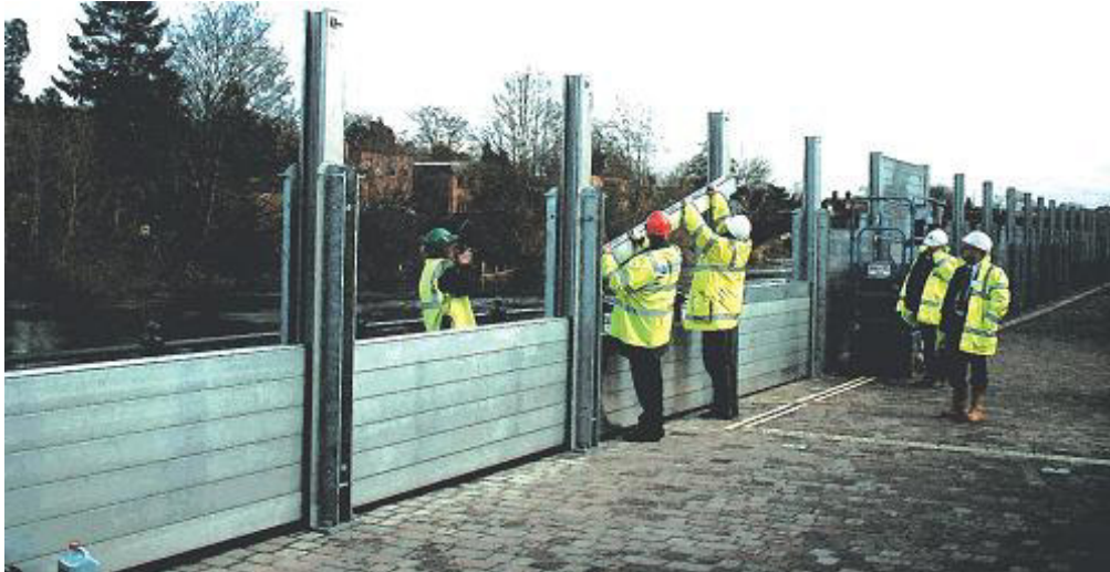
53. ábra: IBS fal építése. (forrás: Domo-bau.hu [128])
