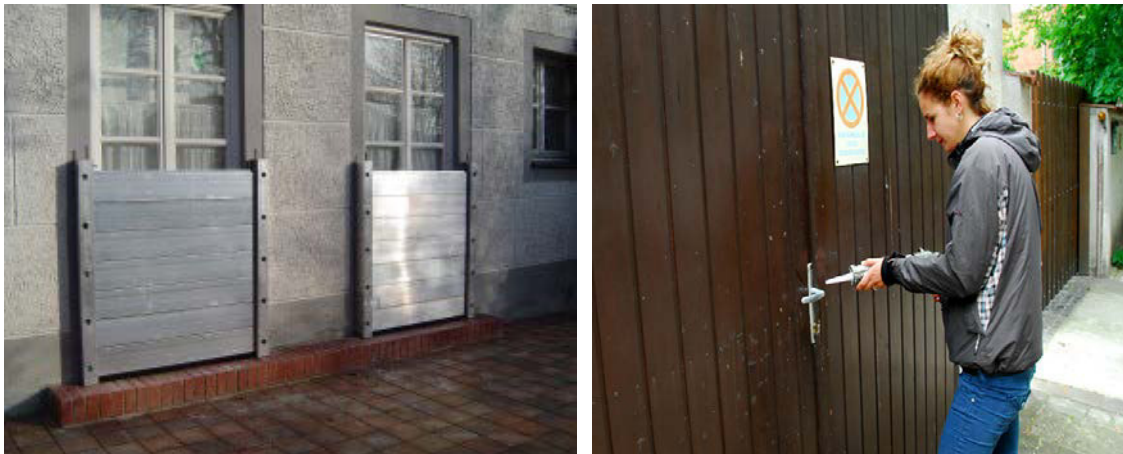
54. ábra: Nyílászárók szakszerű árvízvédelme, szemben a védelmet alig jelentő nem szakszerű egyéb megoldásokkal. (forrás: Hochwasserschutz.de [129])
