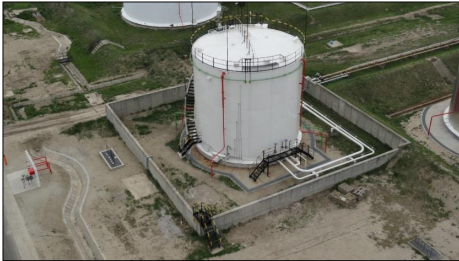
2. fénykép: Beton védőfallal kialakított védőgödör; készítette a szerző 2009.
