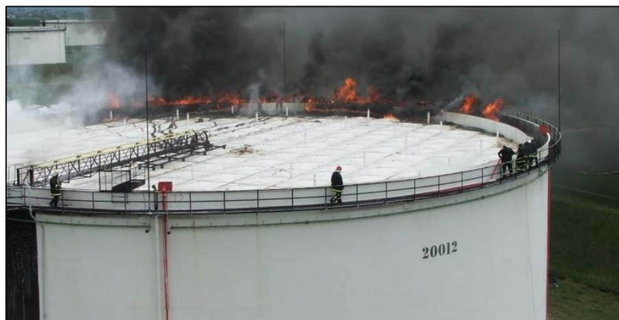
25. fénykép: Tömítőréstűz oltási kísérlet; Forrás: FER tűzoltóság 2015.
