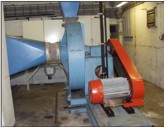
29. számú ábra: A főszellőző ventilátor és a harcgáz szűrők telepítése, beépítése [44]
