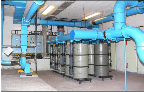
32. számú ábra: A WC csoport szellőző rendszere a szűrőkkel és egy kézmosó blokk kialakítása [44]
