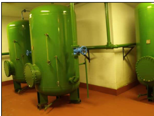
31. számú ábra: A hidrofor tartályok elhelyezésének és az átváltó idom helyének bemutatása
