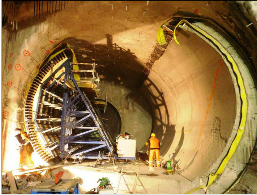
16. számú ábra: Tübbing elemek beépítése a Szent Gellért téri állomás közelében [44]
