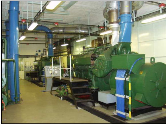
30. számú ábra: A diesel aggregátorok telepítése és a napi üzemanyag tartály [44]
