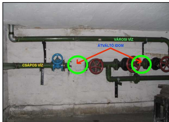
31. számú ábra: A hidrofor tartályok elhelyezésének és az átváltó idom helyének bemutatása
