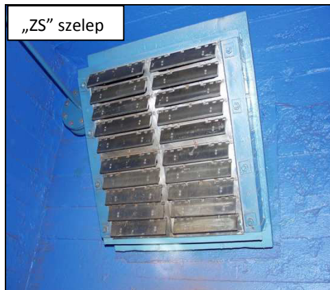
26. számú ábra: A „ZS és „H” szelep kialakítása, beépítése [44]
