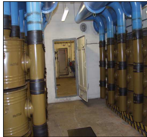
29. számú ábra: A főszellőző ventilátor és a harcgáz szűrők telepítése, beépítése [44]
