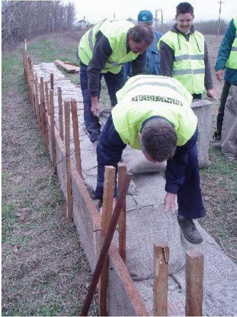
1. sz. fotó: Nyúlgát építése Készítette: Bárdos Zoltán 2010.
