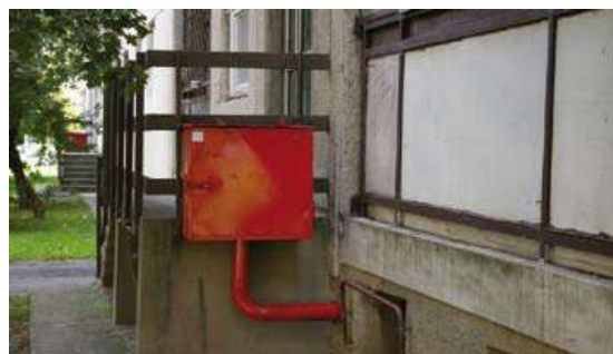
6. fénykép: Nem a tűzoltási felvonulási terület felől került kialakításra a száraz felszálló betáplálási helye (forrás: FKI)
