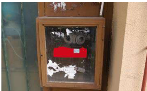
5.: A csatlakozó kapcsok, és a zárószerelvények is hiányoznak a betáplálási helyen (forrás: FKI)
