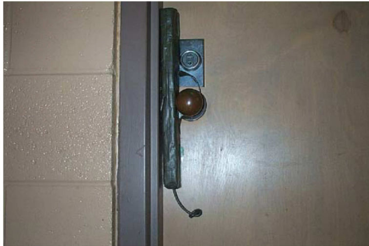
7. ábra Ajtó zárszerkezetének felrobbantása [13]
