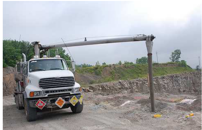
48. ábra Fúrt lyuk betöltése ANDO keverő – töltő berendezéssel [15]
