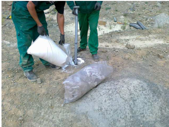
47. ábra Fúrt lyukak betöltése kézi erővel [7]
