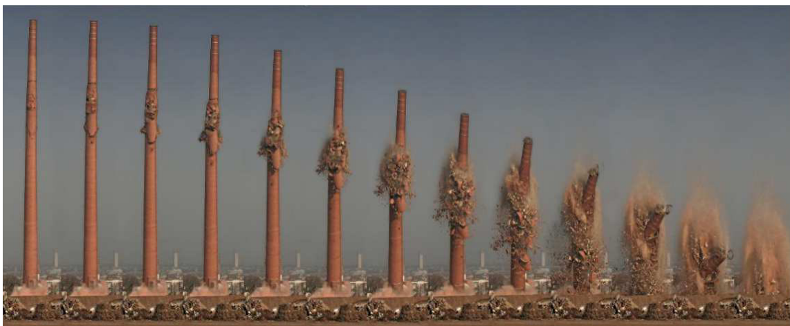
10. ábra Kémény bontása robbantással [20]
