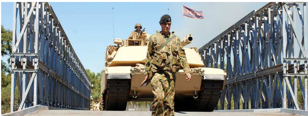
3.4 ábra: speciálisan katonai célra épített Acrow 700XS hídrendszer
