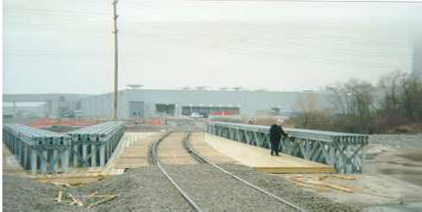
3.3 ábra: MABEY hídrendszerek vasúti hídként történő alkalmazása
