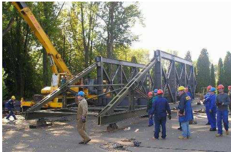
3.9 ábra: Polgári személyek felkészítése a ŽM 16M 37 összeszerelésére - konzol mozgatása
