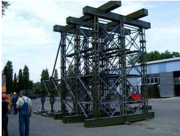
3.6 ábra: Polgári személyek felkészítése a PIŽMO 35 összeszerelésére a CSK Közlekedési Minisztérium kiképzőközpontjában
