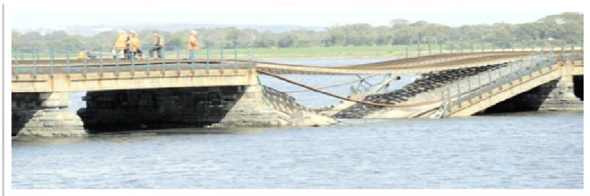
2.1. ábra Vasúti híd összeomlása a Belfast–Dublin vonalon
