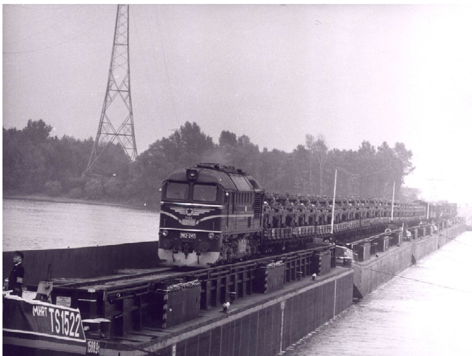
3.2 ábra: Vasúti TS uszályhíd üzemeltetése a Dunán
