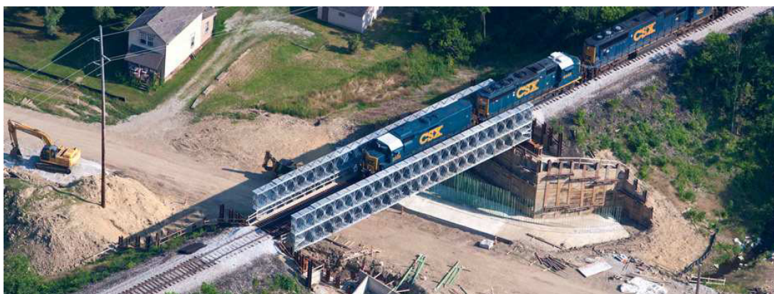
3.5 ábra: Ideiglenes vasúti híd kialakítása Acrow hírendszer felhasználásával
