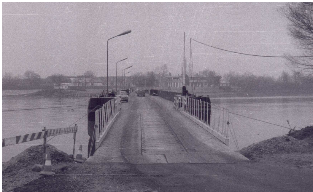
3.1 ábra: Közúti TS uszályhíd telepítése
