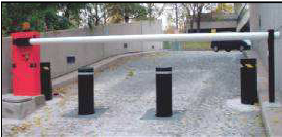
21. kép Útzár kialakítása forgalomkorlátozó oszloppal és sorompóval [87.]
