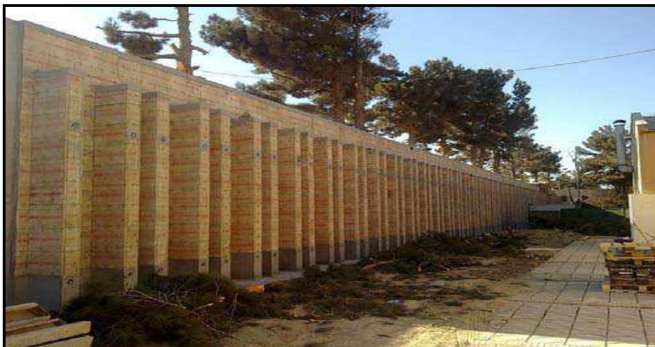
22. kép Az ISAF parancsnokság kerítésének blokkos kialakítása [63.]
